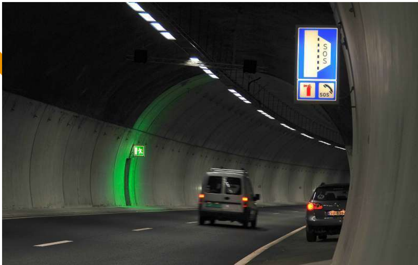
Nødutgang Lys ved nødutgang (Foto: Knut Opeide)
