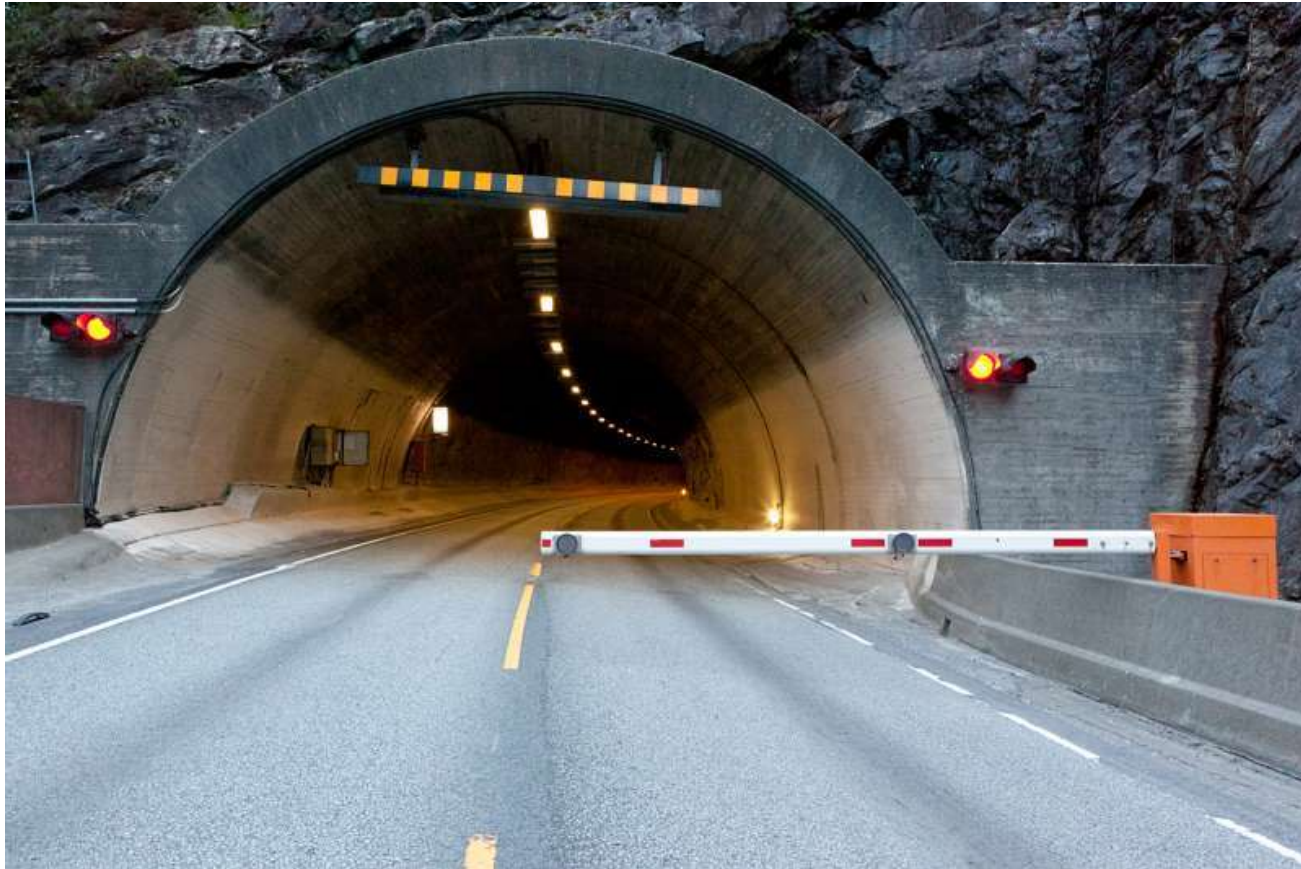
Stengt tunnel Tunnel stengt med bom (Foto: Arild Petter Søvik)
